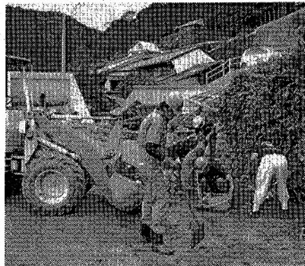
道路の土砂積み込み作業
