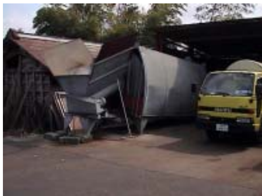
(写真上) 堆肥化プラント 写真右端は生ゴミを収集するパッカー車。
