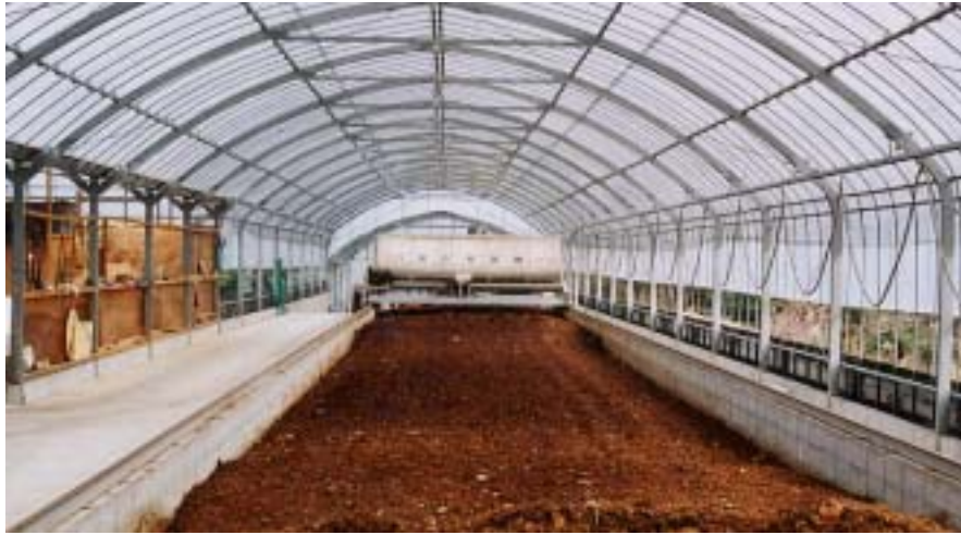
はちがめプラン堆肥化プラント レーン方式。このレーンの中で発酵させながら、順次、機械 によって奥に堆肥が移動して完熟堆肥になっていく。
